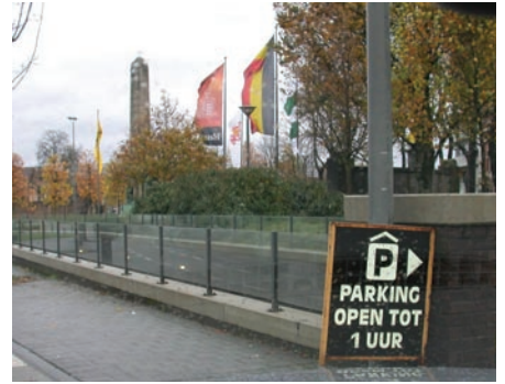
Afb. 9 Ingang van een openbare parking met valrisico.
